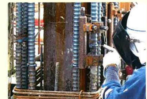
柱筋溶接状況
